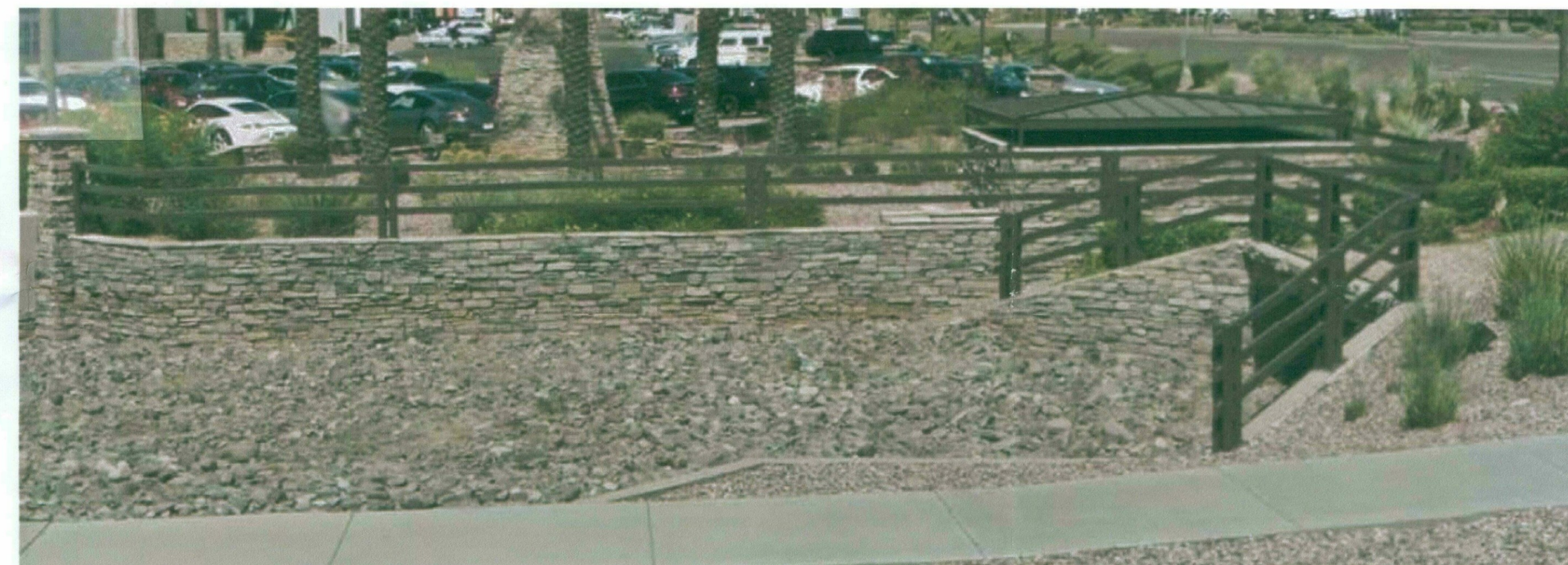
02 SCENIC CORRIDOR TYP. DETAILS - RIP RAP & FENCING SCALE: N.T.S.
