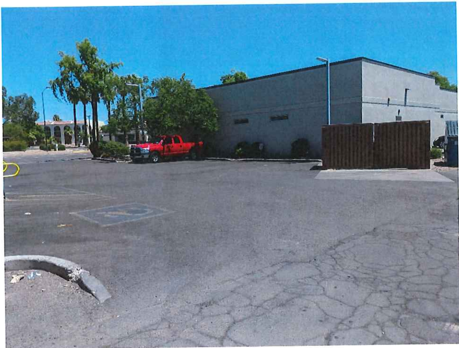
1. NE corner looking NE
