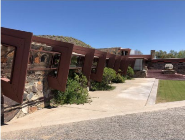
PORTE COCHERE STRUCTURE
